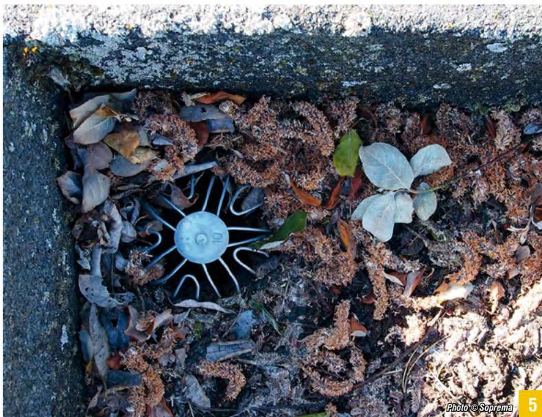
▲ 5 L'évacuation ne fonctionne plus correctement : les feuilles sont bloquées au niveau de la crapaudine et forment un barrage pour l'écoulement des eaux pluviales.
