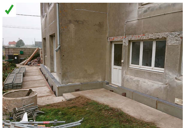
Les dalles ciment de la terrasse sont enlevées sur une largeur d'environ 40 cm, ce qui permet de décaisser le pourtour de la maison et d'isoler le soubassement. ©AQC
