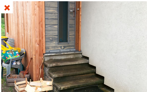
L'escalier en béton n'est pas désolidarisé de la façade isolée par l'extérieur et crée un pont thermique. ©AQC
