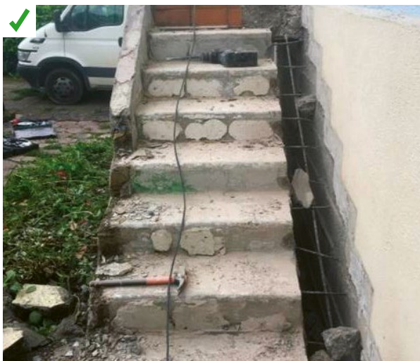
Désolidarisation de l'escalier portant avec suppression du ferrailage avant la mise en œuvre d'une ITE. Les aciers affleurants sont traités contre la corrosion. ©AQC
