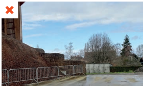
Une partie du stockage du combustible se trouve à l'air libre, en dehors de l'aire protégée des intempéries. ©AQC
