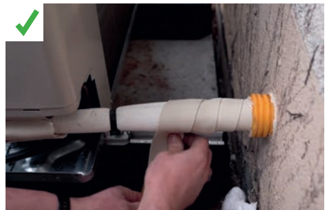
Un complément d'isolation avec un matériau adapté est appliqué sur les parties initialement non calorifugées. © AQC
