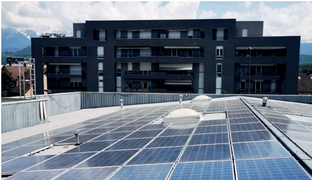
L'inspection de la centrale photovoltaïque sur ce toit-terrasse est sécurisée par l'échelle d'accès et l'acrotère.
