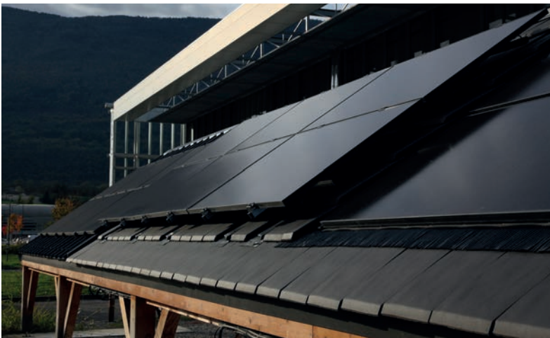
Trois poses sont évaluées sur ce toit pédagogique de la plateforme de formation de l'INES-PFE. Du plus proche au plus loin : intégré au bâti, surimposé, intégration simplifiée.
