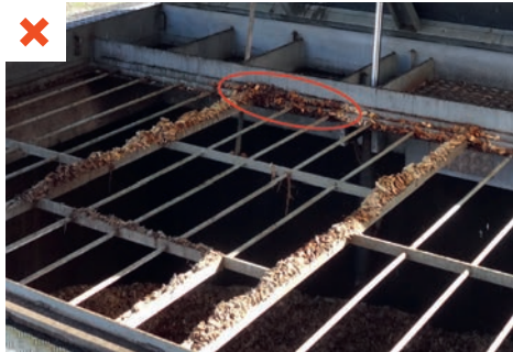
Une partie du combustible, de couleur plus foncée et entourée en rouge sur la photo, est gorgée d'eau. L'ensemble de la livraison n'est pas homogène en termes de taux d'humidité. ©AQC
