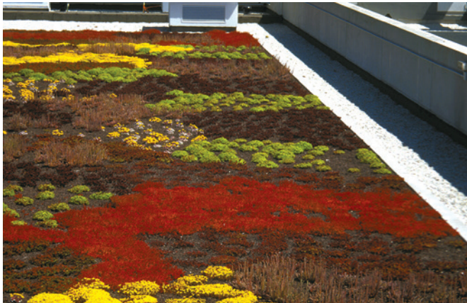
Figure 2 : Exemple de toiture-terrasse végétalisée
