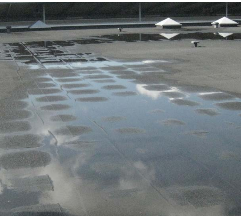
Cintrage de panneaux isolants en polyuréthane sous membrane d'étanchéité. (source : Eurisk)
