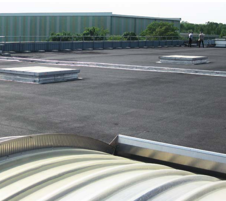
Terrasses avec revêtement auto-protégé et sous protection meuble par gravillons. (source : Eurisk)
