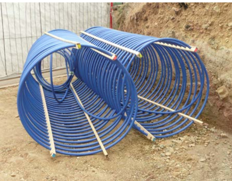
Figure 4 : échangeur fermé, corbeille géothermique ©AQOC
