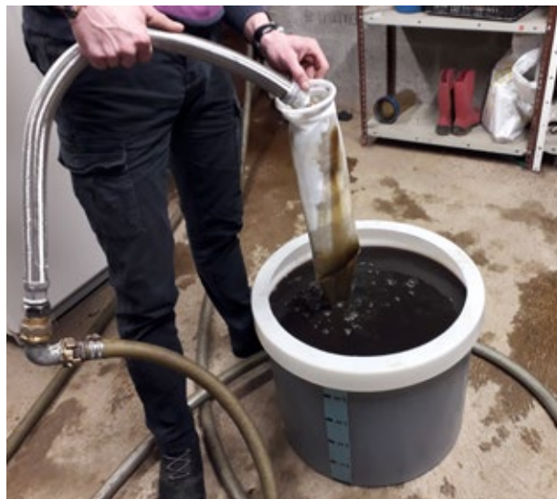
12. Désembouage d'un plancher chauffant. L'eau du réseau est de couleur noire et chargée de matières en suspension. (Crédit photo : Eurisk)
