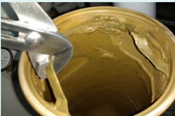
13. Filtre magnétique sur le retour général du réseau en chaufferie
