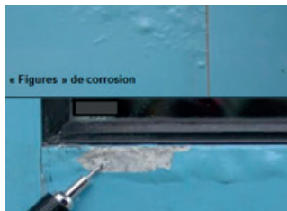
La propagation se fait dans la direction opposée à la zone aérée
