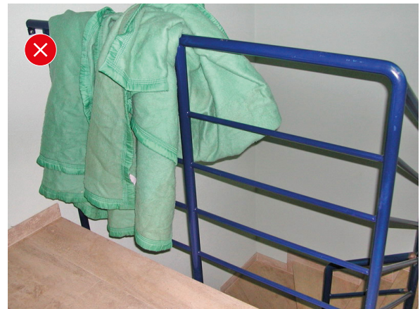
2. Effet échelle, sur palier d'escalier.
