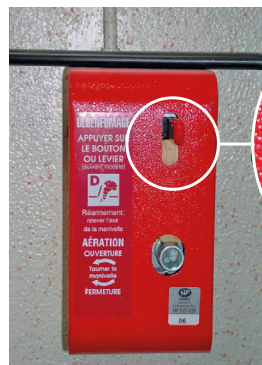
2. Levier de manœuvre bloqué par un bout de bois.
