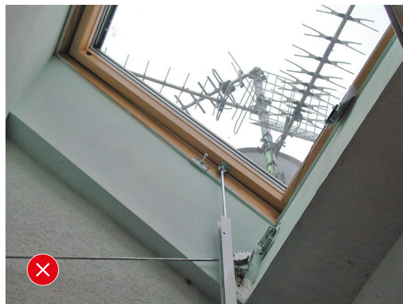
3. Vérin hors-service et poulie arrachée de son support.
