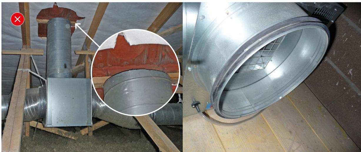
1. L'air vicié est soufflé dans les combles, des particules enflammées peuvent être projetées.
