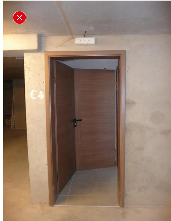
3. Dimensions du sas insuffisantes, les portes restent bloquées en position ouverte.
