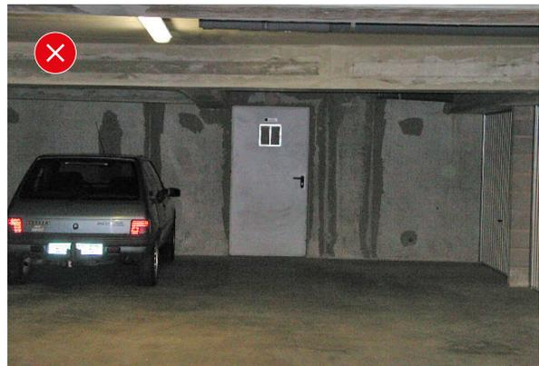
3. Sortie de secours non signalée par foyers lumineux. Ouverture en partie haute pour le désenfumage insuffisante.
