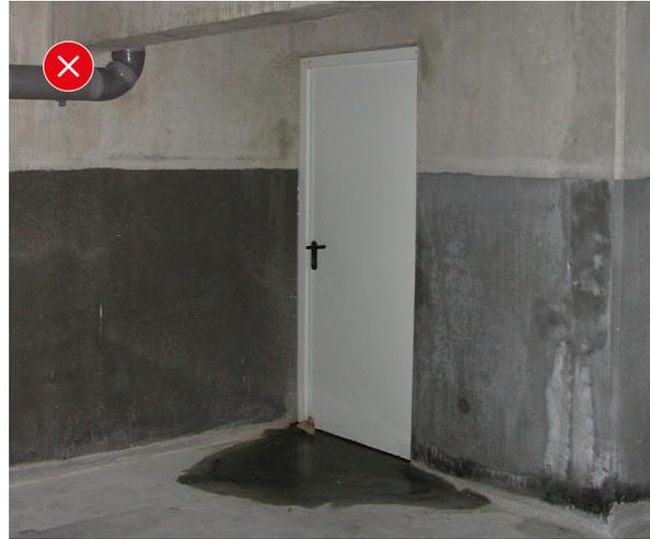
1. Porte de sortie de secours donnant sur l'extérieur : pas de foyers lumineux, pas d'ouverture en partie haute, possibilité de fermer avec une clé ; c'est pourtant une sortie de secours.
