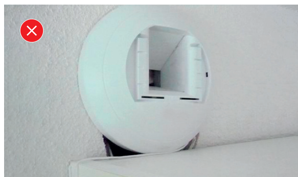
3. Sortie d'air modifiée pour l'installation de mobilier.
