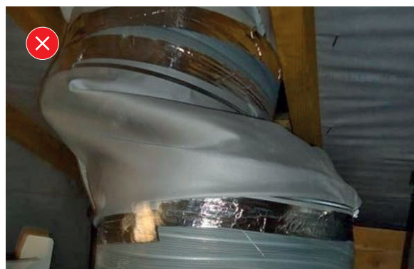
7. Diminution de la section du conduit.
