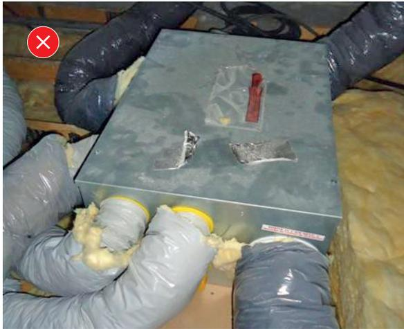
**8.** Caisson motorisation double flux non fixé, posé sur matériau résiliant reposant lui-même sur deux fermettes de la charpente.
