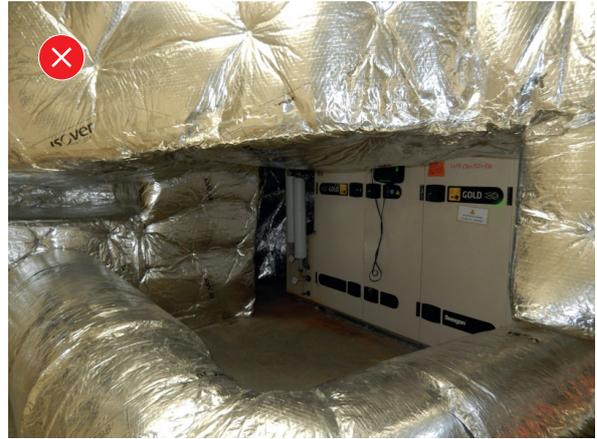
**9.** Le cheminement et l'encombrement du réseau aéraulique empêchent un accès aisé à la CTA.
