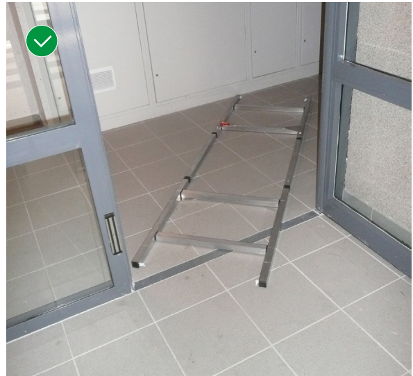
4. Vérification de passage du brancard.
