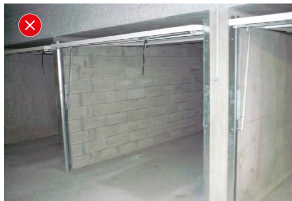
9. Porte de box non manœuvrable par des personnes à mobilité réduite y compris en fauteuil roulant (effort d'ouverture, atteinte des commandes).
