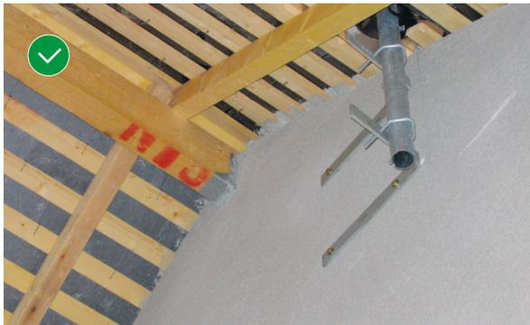
3. Une paroi séparative allant jusqu'à la toiture empêche la transmission du bruit par les combles entre des locaux situés au dernier étage.
