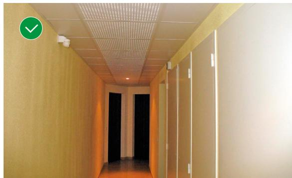
4. Circulation traitée en faux-plafond avec répartition homogène des éléments absorbants (dalles perforées).
