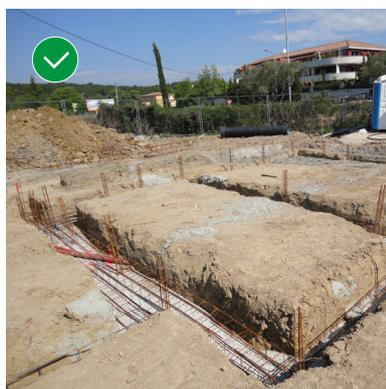
1. Les chaînages verticaux descendent jusqu'aux fondations dans lesquelles ils sont ancrés.
