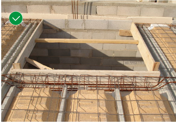
3. Renforcement des encadrements de trémies.
