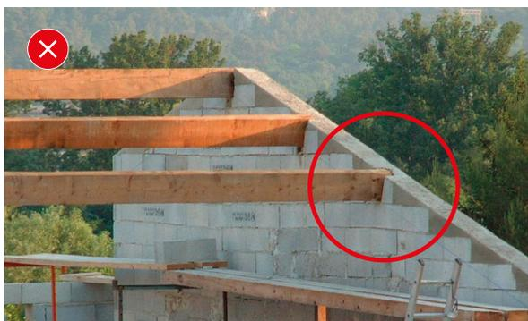
2. Les pannes viennent sectionner le chaînage au niveau du rampant.
