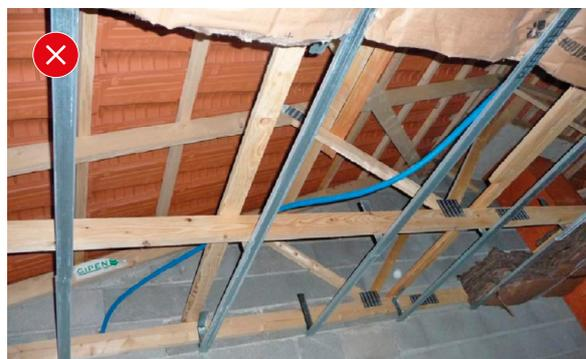
3. Absence de contreventement au niveau des entrants et absence de fixation de la charpente au niveau du pignon.
