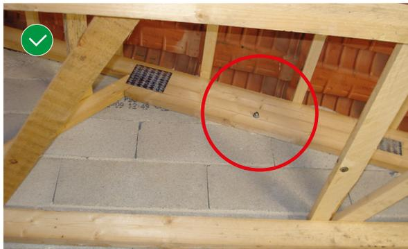
4. La fermette est fixée dans le pignon par la mise en place d'un tire-fond.
