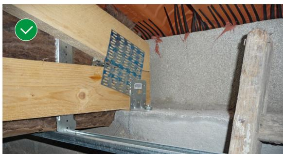
6. La fermette est fixée par équerre de fixation et chevilles dans le chaînage.
