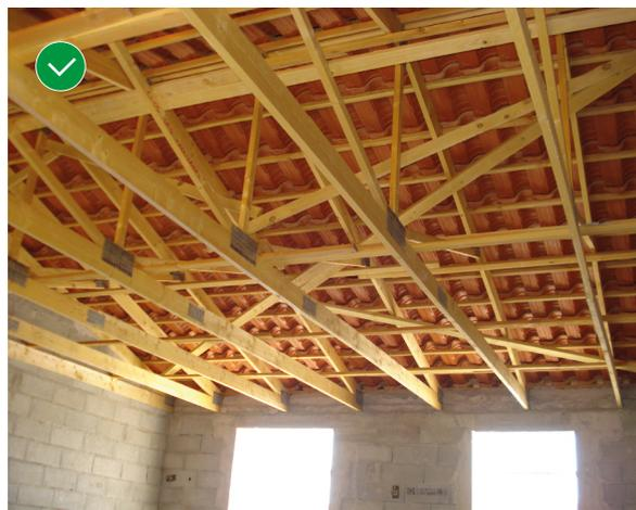
5. Le contreventement horizontal de la charpente est assuré au niveau des entrants.
