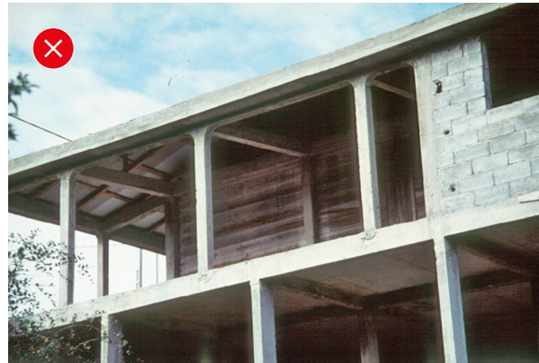
1. Les poteaux ne sont pas superposés d'un étage à l'autre. La descente de charge s'effectue en baionnette ce qui ne favorise pas un bon comportement sismique.
