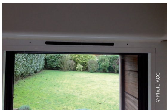
✅ Mortaise réalisée selon les règles de l'art
