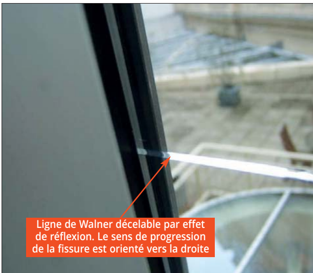
Gradient thermique de faible amplitude (fissure monofilaire)
