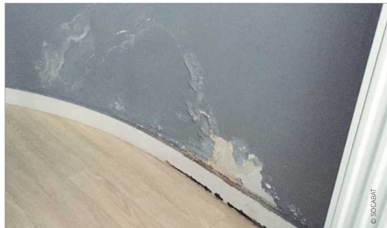
Conséquence en intérieur – condensations ou infiltrations
