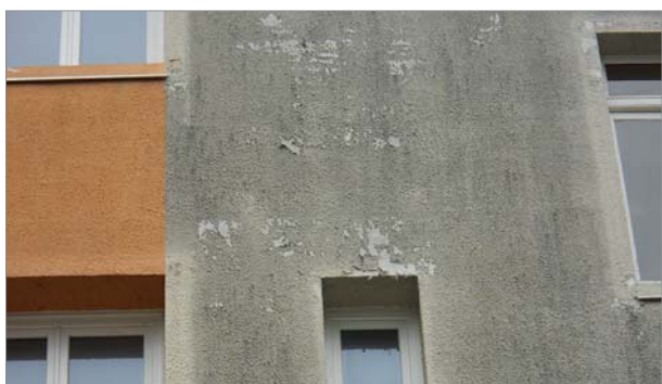
Spectres : joints visibles en lumière rasante par transparence avec accumulation de poussières.
