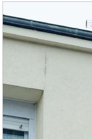
Défaut fréquent : Angles de baie sans renfort de type mouchoir ni coupe en L de l'isolant (voir bonnes pratiques ci-avant).
