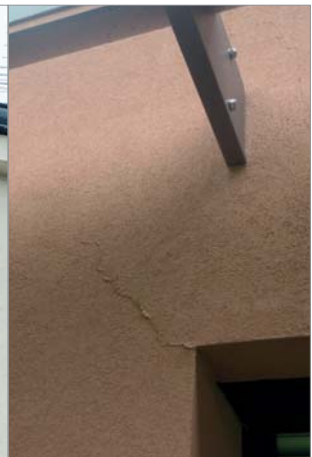
Défaut fréquent : Angles de baie sans renfort de type mouchoir ni coupe en L de l'isolant (voir bonnes pratiques ci-avant).
