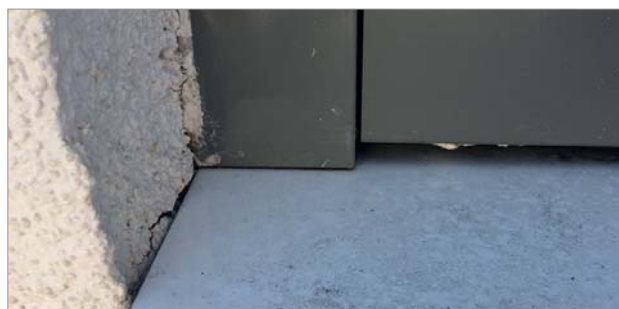
Bavettes ne disposant d'aucune oreille de protection latérale. Jonction infiltrante en tableau de fenêtre contre la partie horizontale et verticale de l'ITE. Absence de rejingot à l'arrière (sous la pièce d'appui de la menuiserie) empêchant l'infiltration d'eau de pluie orientée par le vent. Pente non conforme de la bavette Jour important entre la traverse basse du mur rideau et la bavette. Absence de calfeutrement de joint.
