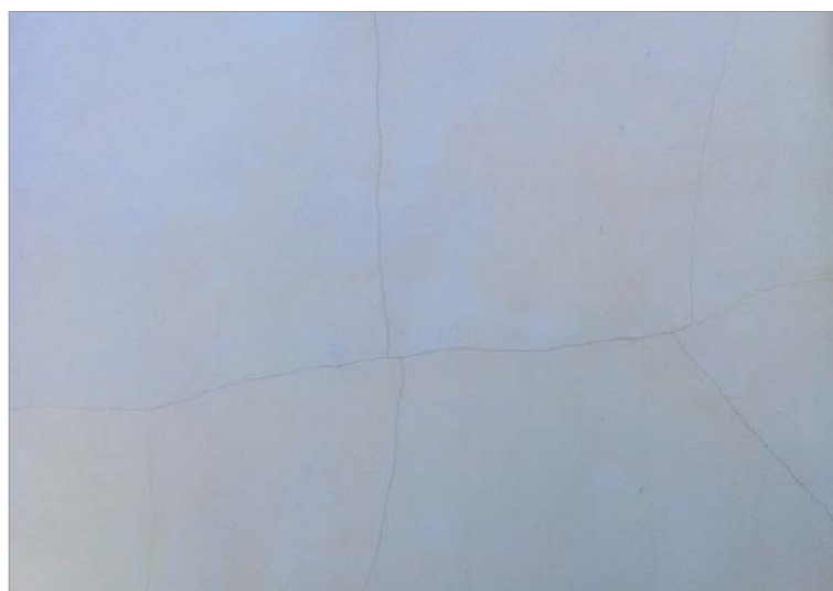
Fissures sur finition chaux (Maille de 50 cm).
