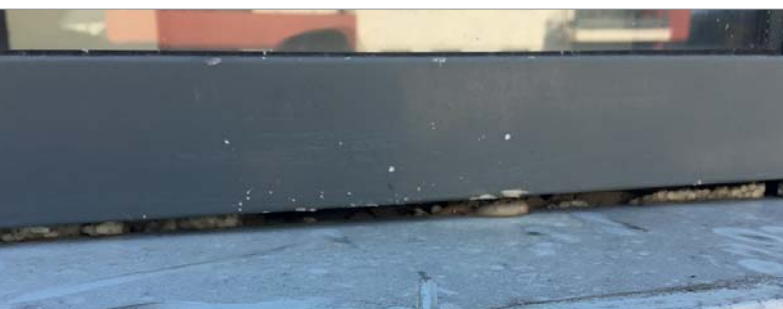
Bavettes ne disposant d'aucune oreille de protection latérale. Jonction infiltrante en tableau de fenêtre contre la partie horizontale et verticale de l'ITE. Absence de rejingot à l'arrière (sous la pièce d'appui de la menuiserie) empêchant l'infiltration d'eau de pluie orientée par le vent. Pente non conforme de la bavette Jour important entre la traverse basse du mur rideau et la bavette. Absence de calfeutrement de joint.
