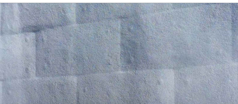
Spectres : joints visibles en lumière rasante par transparence avec accumulation de poussières.
