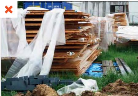
Exemple d'un stockage d'éléments bois mal protégés des intempéries et en contact avec l'humidité du sol.
