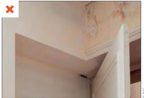
*Pour permettre l'ouverture complète de la porte fixée à la base du mur de refend, l'isolation thermique par l'intérieur n'a pas été réalisée derrière celle-ci. La différence de température de la paroi provoque de l'inconfort thermique, favorise la condensation et l'apparition de moisissures.*
