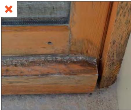
La partie basse de la menuiserie est la plus vulnérable car la plus exposée aux intempéries.
