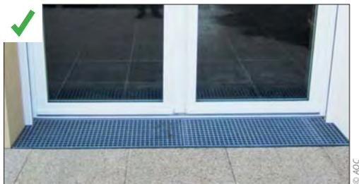
Exemple de solutions avec le système de dalle sur plot en extérieur. Source : Cahier du CSTB : Carnets de détails pour l'accessibilité des balcons, des loggias et des terrasses dans les constructions neuves.
