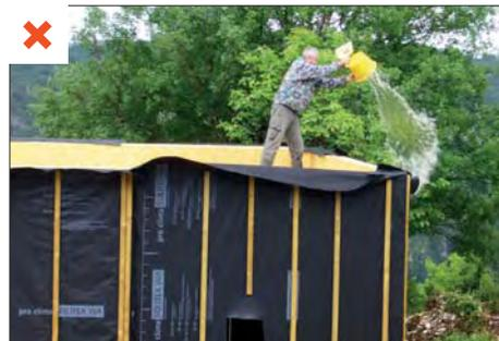
Le bâtiment non protégé (notamment les éléments bois au niveau de la toiture terrasse) est resté longtemps exposé aux intempéries avant d'être mis hors d'eau.
