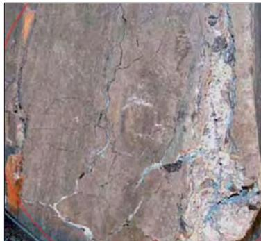
Le sinistre sériel du béton de la Maurienne, découvert en 2006 : les analyses conclurent à une attaque sulfatique interne généralisée des bétons, consécutive à la présence de gypse dans les granulats utilisés pour sa fabrication, entraînant la désagrégation et la ruine du béton exposé à l'humidité.
