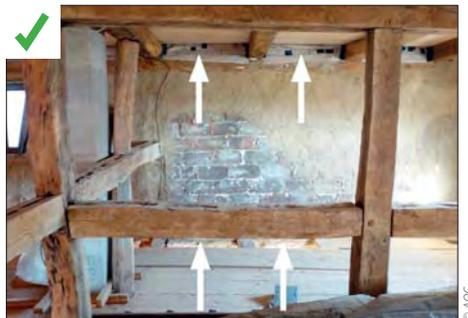
*Un vide a été créé entre les planchers intermédiaires et les murs. Cela permet de poser une membrane pare-vapeur en continu, et d'obtenir une continuité d'isolation entre les étages.*
