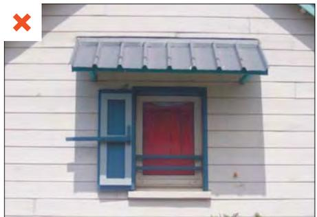
Protection solaire en tôle provoquant une surchauffe locale au niveau de l'ouverture.
