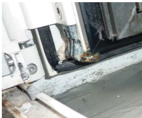
Déformation d'une contre-plaque de paumelle, précédant la chute du vantail.
