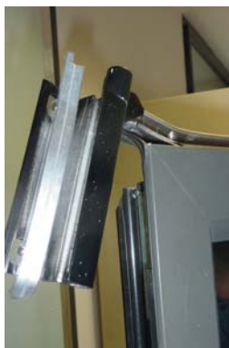
Arrachement de paumelle haute de châssis oscillo-battant.
