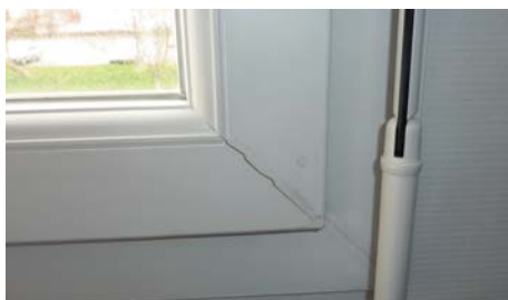
Casse de soudure d'angle sur menuiserie PVC.
