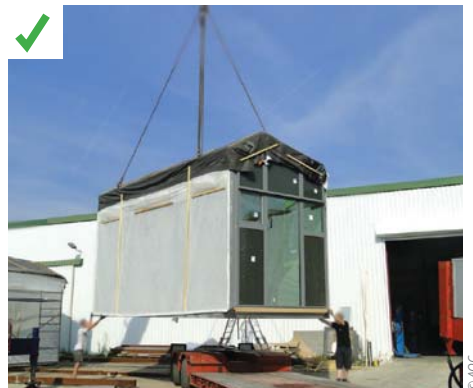
Chargement d'un module en sortie d'atelier. Les parois « ouvertes » sont bâchées pour éviter les déformations lors des opérations de levage et pendant le transport.
