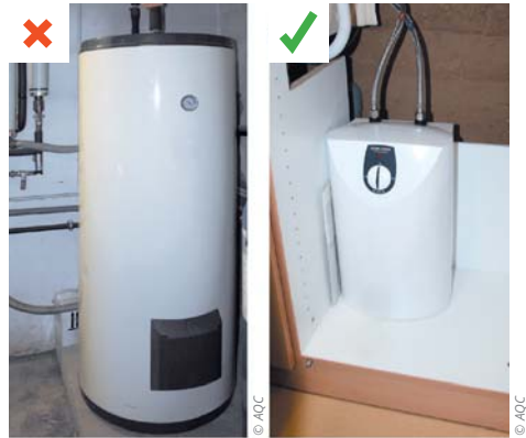
Ballon ECS en chaufferie relié à un long bouclage de distribution imposant le maintien en chauffe des chaudières (2 x 600 kW).
