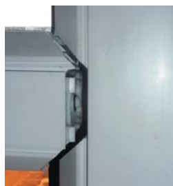
Défaut d'assemblage montant/traverse.
