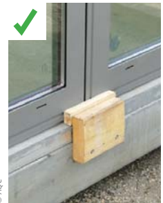
Des cales de bois empêchent l'ouverture intempestive des menuiseries.
