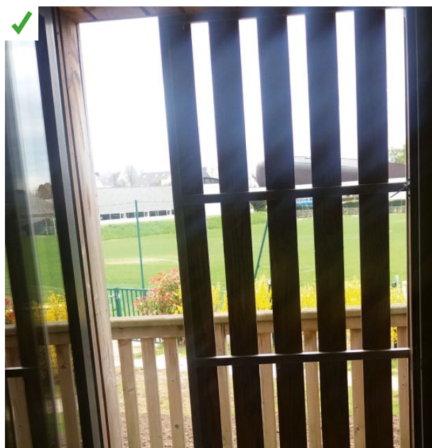
Brise-soleil à lames verticales posé sur rail. ©AQC
