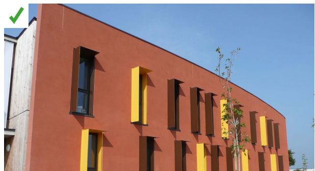
Sur cette façade à l'Est, la mise en œuvre d'œillères correctement dimensionnées permet une protection solaire efficace. ©AQC
