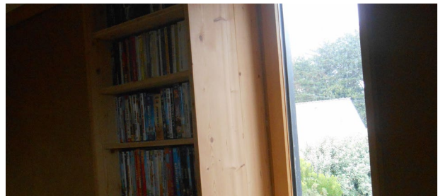
Une isolation thermique par l'extérieur (ITE) a été mise en œuvre sur la maçonnerie existante. Cette ITE a été prolongée afin de diminuer les ouvertures au Nord de moitié pour ne conserver qu'un bandeau vertical. L'absence de maçonnerie sur la moitié de l'ouverture initiale a été utilisée pour inclure une bibliothèque. ©AQC
