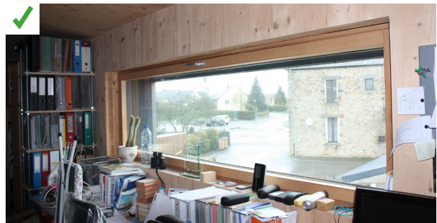
Sur la façade Nord, un bandeau horizontal équipé d'un triple vitrage a été mis en œuvre. ©AQC
