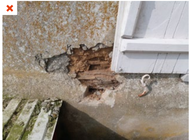
L'enduit ciment existant va être remplacé par un enduit présentant des propriétés isolantes. ©AQC
