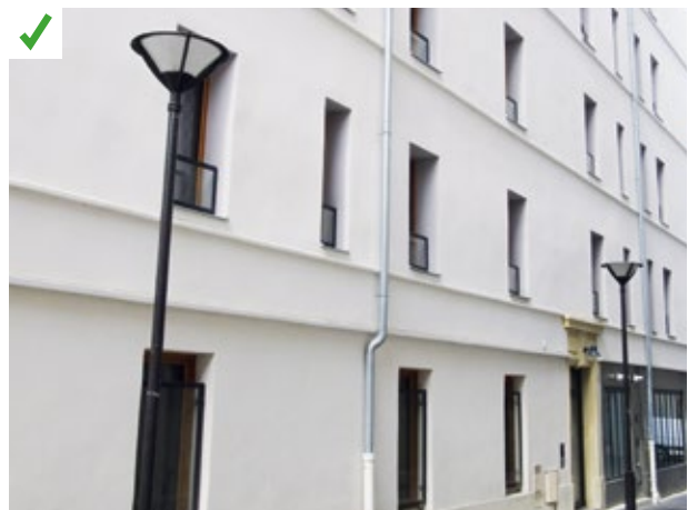
Les interstices entre les pans de bois ont été curetés du plâtre. Un isolant en fibres végétales a été inséré à la place en remplissage et des panneaux d'isolant en fibres végétales haute densité ont été fixés de part et d'autre de l'ossature en pan de bois. ©AQC
