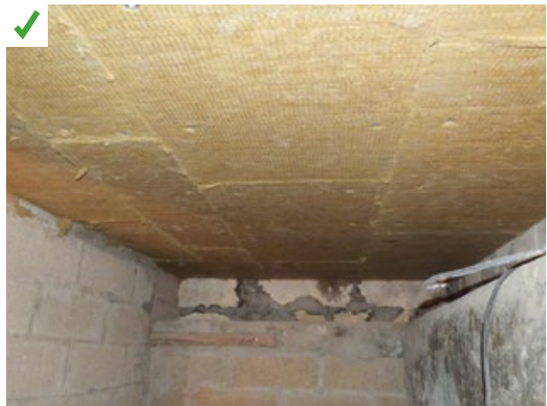
Dans ce petit pavillon de 1925 le plancher bas sur vide sanitaire a pu être isolé en partie dans l'épaisseur à l'aide de panneaux de 12 cm de laine minérale insérés entre les solives. Une seconde couche croisée de 6 cm a été fixée par-dessous. ©AQC
