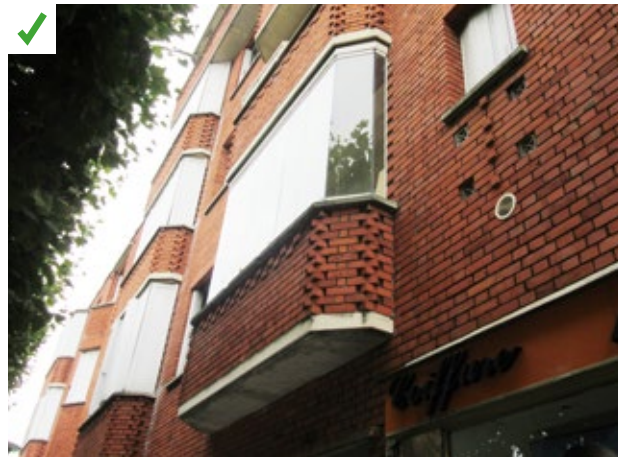
Les loggias ont été vitrées pour réaliser un jardin d'hiver et permettre une amélioration du confort thermique et acoustique. Le confort d'été n'a pas été dégradé grâce à la présence des arbres à feuilles caduques le long de la façade. ©AQC
