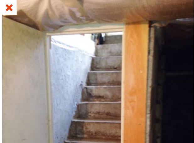
Cage d'escalier non isolée. ©AQC
