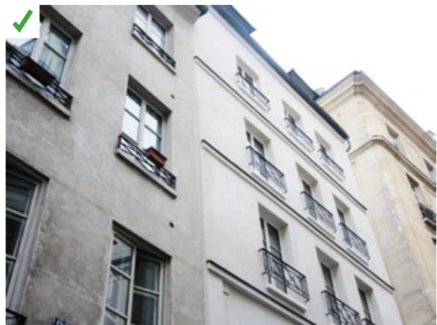
Pose en extérieur d'un enduit chaux chanvre protégé par un enduit de finition chaux sable. En intérieur, la pierre est habillée d'enduit chaux chanvre projeté, recouvert d'un enduit de finition à la chaux. Les interstices entre les pans de bois ont été curetés du plâtre. Un isolant en fibres végétales a été inséré à la place en remplissage et des panneaux d'isolant en fibres végétales haute densité ont été fixés de part et d'autre de l'ossature en pan de bois. ©AQC
