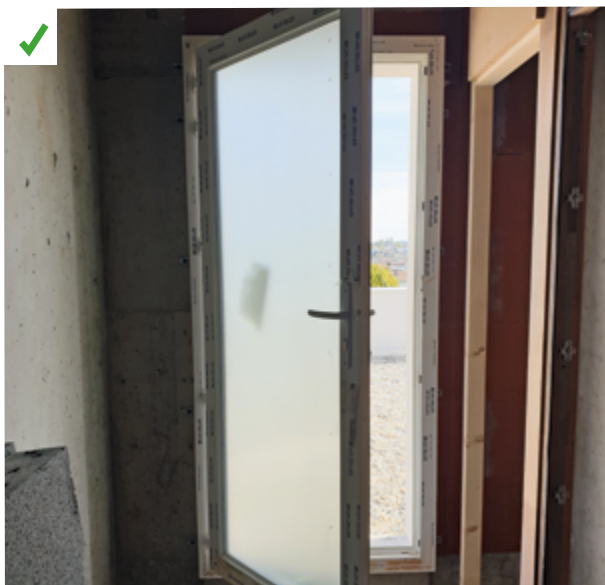
La porte d'accès à la toiture terrasse est vitrée et permet de bénéficier de la lumière naturelle dans la circulation commune. ©AQC
