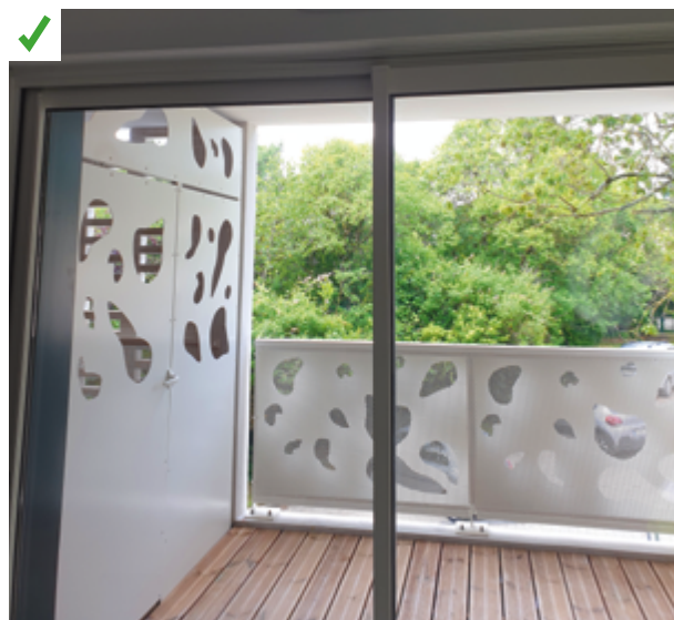
L'intimité dans la pièce de vie est préservée par un garde-corps et un cloisonnement limitant les vis-à-vis et les désagréments climatiques. La loggia aménagée permet un espace de vie supplémentaire très plébiscité par les usagers. ©AQC
