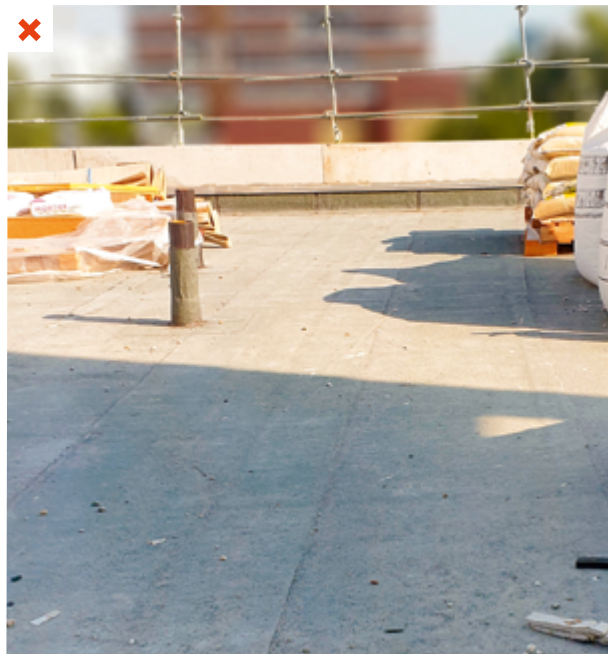
Des matériaux sont entreposés temporairement sur la toiture terrasse. Cela constitue un risque de détérioration du revêtement d'étanchéité. ©AQC
