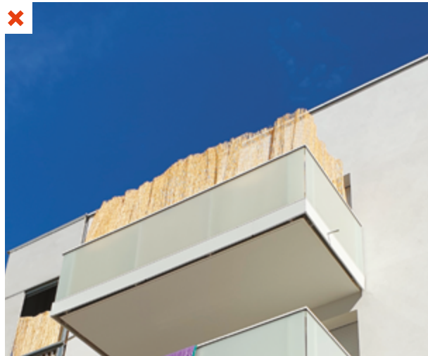
Malgré la présence de garde-corps translucide, les occupants mettent en place des brise-vues dont la hauteur s'avère pénalisante pour les apports solaires d'hiver. ©AQC
