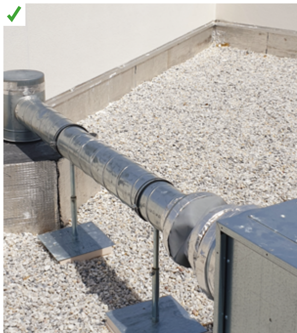
La toiture terrasse permet l'implantation d'équipements techniques tels que les groupes de ventilation. Les relevés d'étanchéité sont réalisés avec soin. ©AQC
