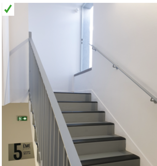
L'accès à la toiture terrasse est facilité par la présence de l'escalier. ©AQC
