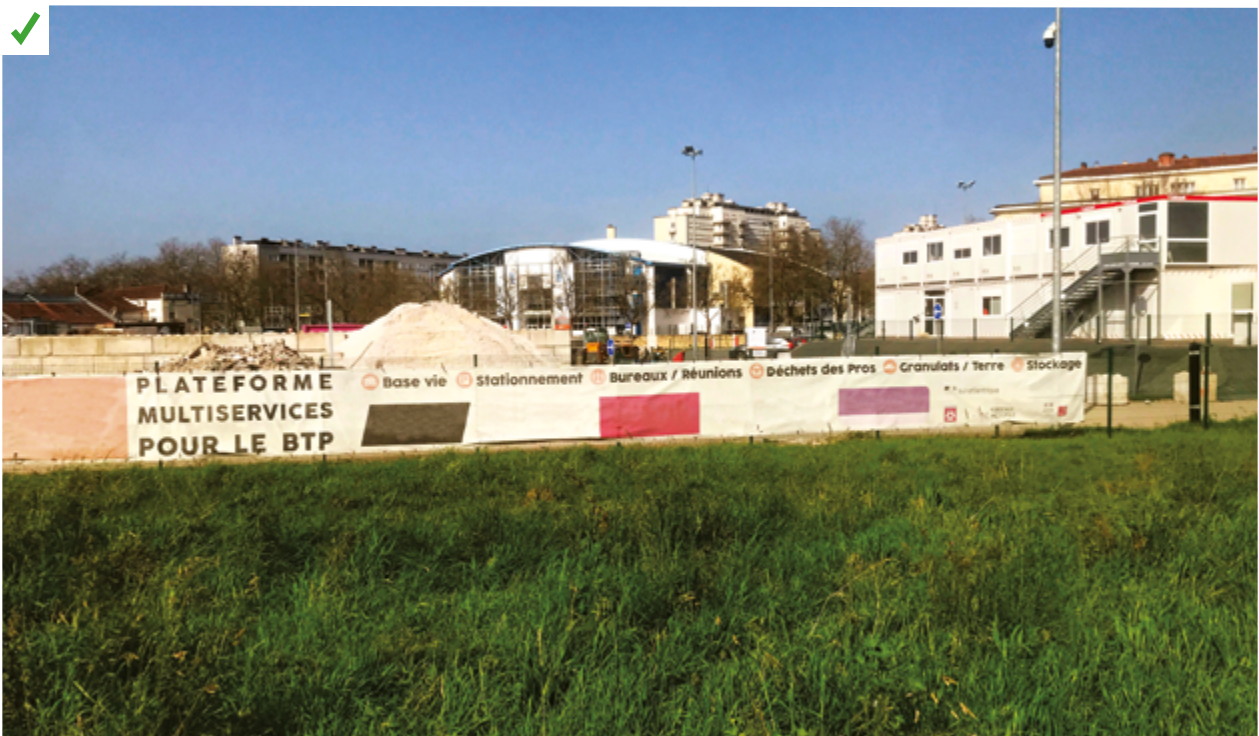
Une plateforme de services mutualisés interchantiers a été créée. Ce type d'initiative contribue à répondre au problème de sécurité et à réduire l'impact environnemental d'un chantier. Une zone de parkings et des navettes sont notamment proposées pour faciliter les déplacements. ©AQC
