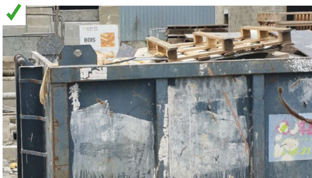
Les déchets sont triés sur chantier, la benne « bois » est clairement identifiée. ©AQC
