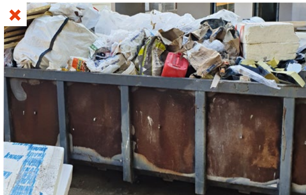
Les déchets non dangereux et non inertes sont entreposés dans une seule benne. Les déchets ne sont pas triés sur chantier. ©AQC
