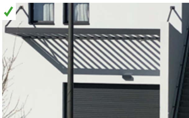
Brise-soleil bien dimensionné pour laisser entrer le soleil en hiver et le masquer en été. ©AQC
