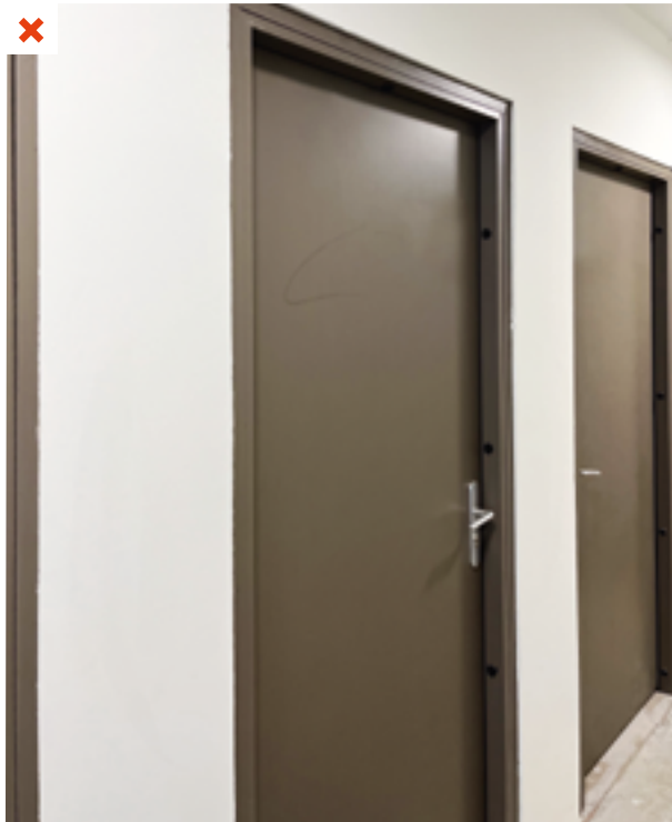
Cet appartement dispose de deux portes palières mais d'un seul réseau d'eau et d'énergie, ce qui est peu flexible pour une transformation en deux appartements indépendants. ©AQC
