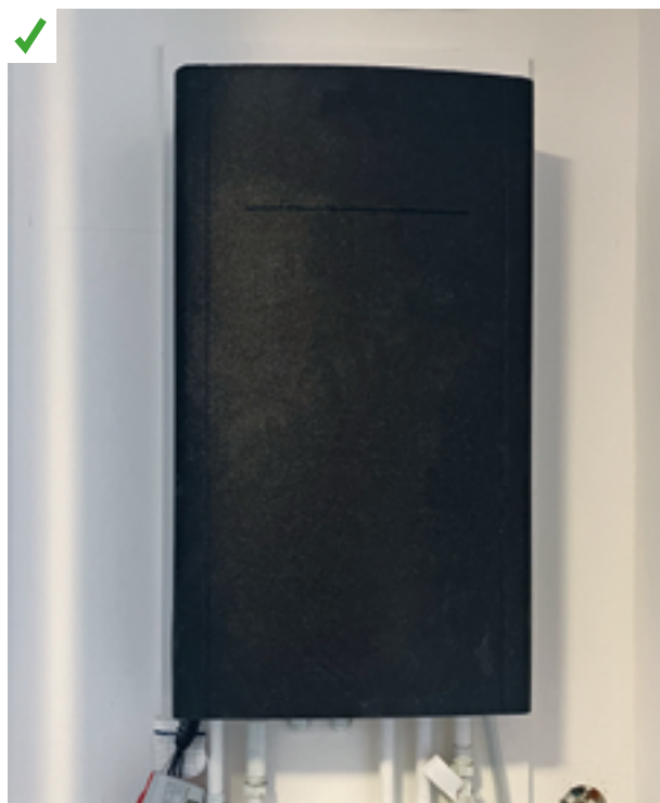
Module thermique d'appartement protégé par une coque isolante qui évite les surchauffes. ©AQC
