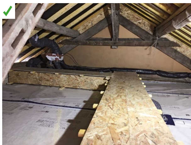
Le cheminement technique (caisson isolé) permet d'inspecter l'ensemble des combles et d'intervenir aisément sur le groupe de ventilation. ©AQC
