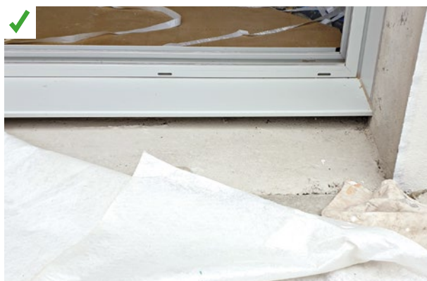
Le seuil de la baie coulissante a été créé. ©AQC
