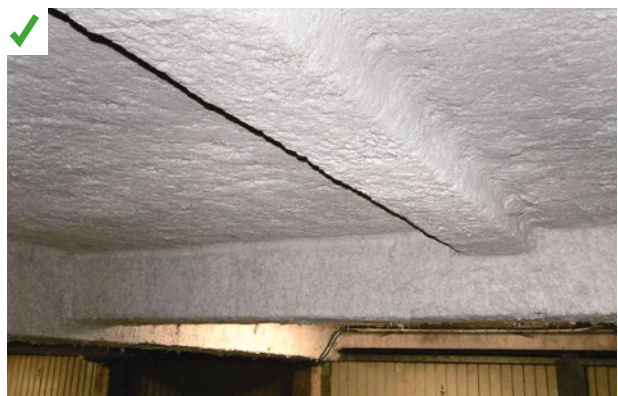
Les poutres en béton de ce garage ont été isolées sur toutes leurs faces (procédé de projection de laine minérale avec liants). ©AQC
