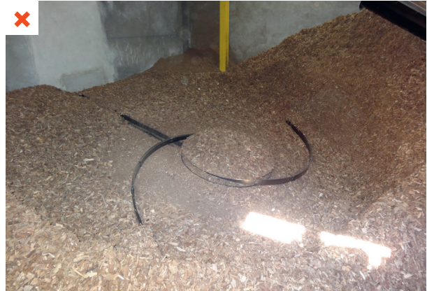
En fin de saison, le silo n'a pas été vidé et la maintenance du silo et du dessileur est rendue difficile. ©AQC
