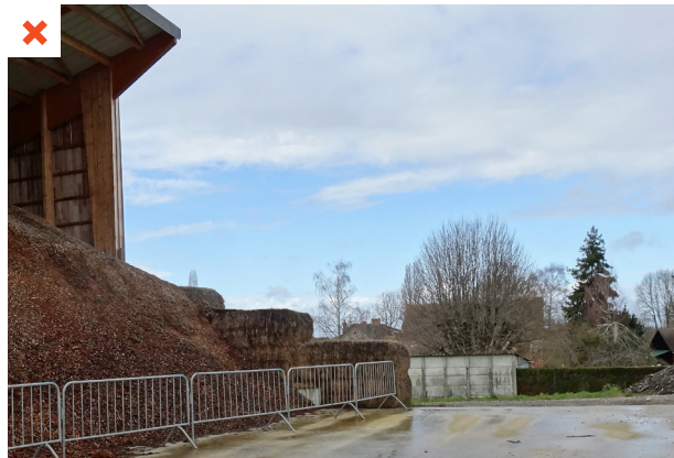
Une partie du stockage du combustible se trouve à l'air libre, en dehors de l'aire protégée des intempéries. ©AQC
