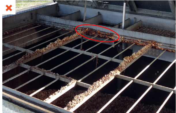
Une partie du combustible, de couleur plus foncée et entourée en rouge sur la photo, est gorgée d'eau. L'ensemble de la livraison n'est pas homogène en termes de taux d'humidité.
