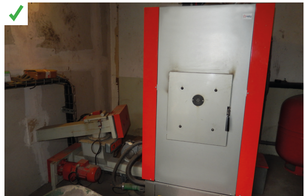
Vis sans fin d'alimentation directe entre le silo de stockage et le foyer avec un angle inférieur à 15°. ©AQC
