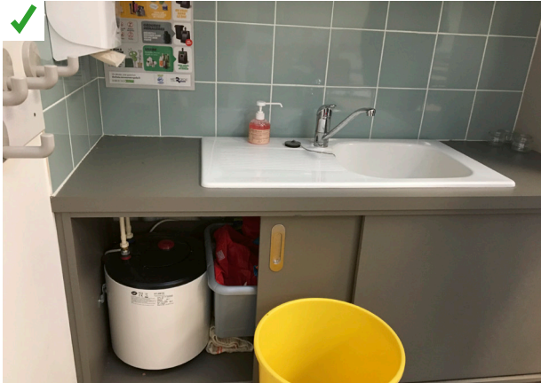
Un ballon d'eau chaude est situé à proximité d'un seul point de puisage. En cas de besoin, l'eau chaude est instantanément disponible. ©AQC
