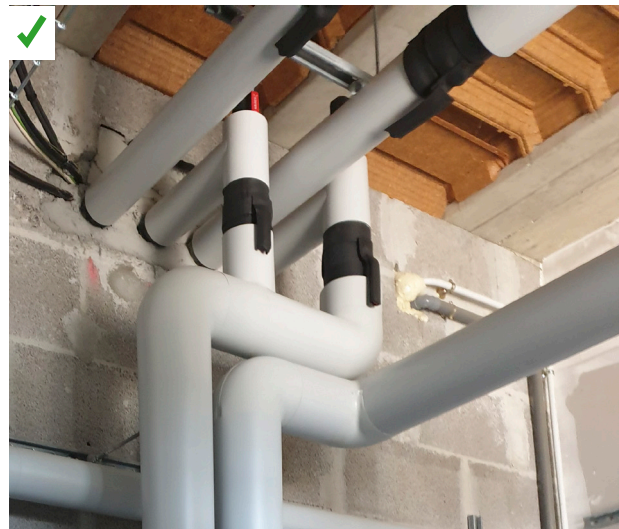
Dans ce local technique, les tuyauteries et organes de réglage sont correctement isolés. ©AQC
