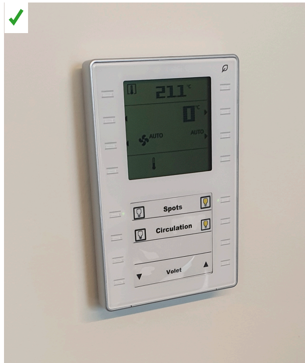
Simplicité de gestion du chauffage, de la climatisation, des volets roulants et de l'éclairage depuis le même module. ©AQC
