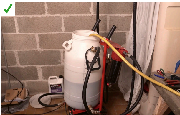
La programmation et la réalisation d'une opération de désembouage hydrodynamique ont été anticipées et planifiées suite au diagnostic du réseau existant fortement encrassé. ©AQC
