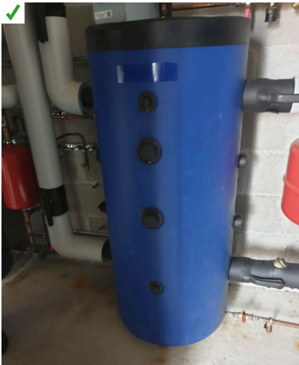
Le ballon tampon est dimensionné de façon à limiter les risques de courts-cycles à faible charge. Dans cet exemple, il assure aussi le rôle de bouteille de découplage et permet de maintenir un débit minimal au niveau de la PAC. ©AQC
