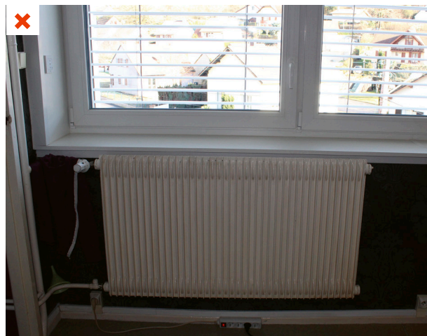
Depuis le changement du générateur modifiant le régime d'eau de l'installation, certains radiateurs ont une surface d'échange insuffisante. ©AQC
