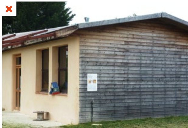
Bardage directement en contact avec un sol humide : non-respect du DTU avec risque de remontée capillaire. ©AQC
