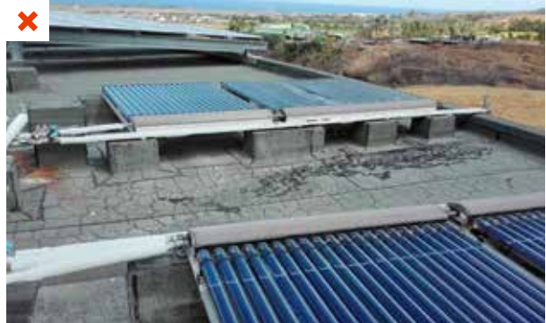
Installation solaire commune à deux espaces distincts. Les linéaires de distribution entre les nappes de capteurs et le stockage sont importants. ©AQC
