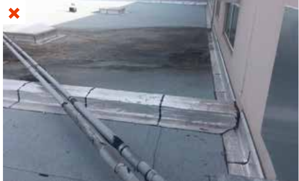
Calorifuge dégradé : produit sensible aux UV et nécessitant un entretien régulier qui n'a pas été effectué. ©AQC
