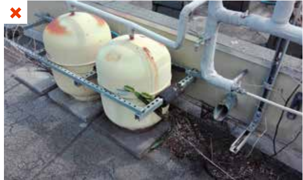
Vases d'expansion hors service sur l'installation solaire du fait du manque de suivi et de maintenance. ©AQC
