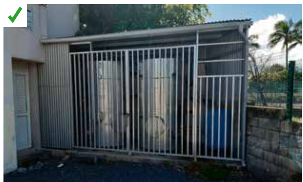
À défaut d'espace suffisant dans le bâtiment existant, le local technique a été implanté en extérieur. L'accès sécurisé est simple et l'espace suffisant pour les interventions. ©AQC
