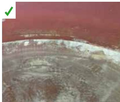
Nettoyage interne complet d'un ballon ECS afin de limiter la corrosion : enlever les boues et résidus en fond de ballon dans le cadre d'une maintenance complète tous les 5 ans. ©AQC
