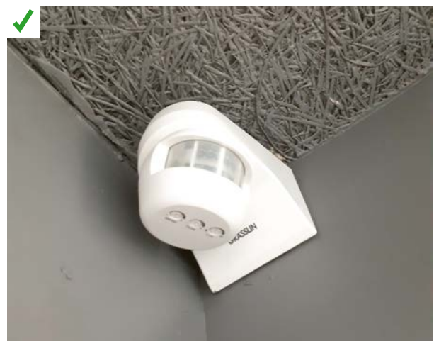
Le réglage de la luminosité, de la temporisation de l'éclairage et de la sensibilité/portée est possible grâce aux trois potentiomètres. ©AQC
