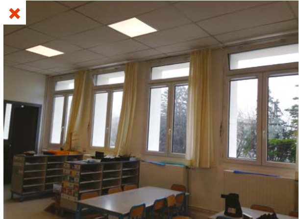
L'éclairage artificiel s'est déclenché alors que les apports naturels sont suffisants. ©AQC
