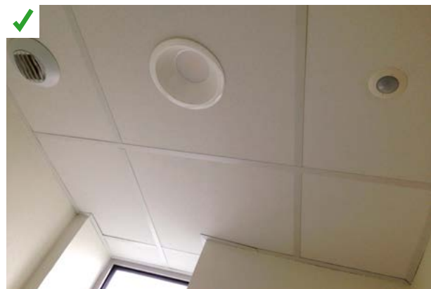
L'allumage ne se déclenche pas, car la lumière naturelle est suffisante. ©AQC
