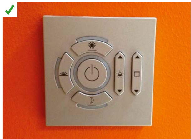
Présence d'un éclairage dynamique dans une école. La température de couleur est gérée par l'utilisateur via un interrupteur selon les moments de la journée. ©AQQC
