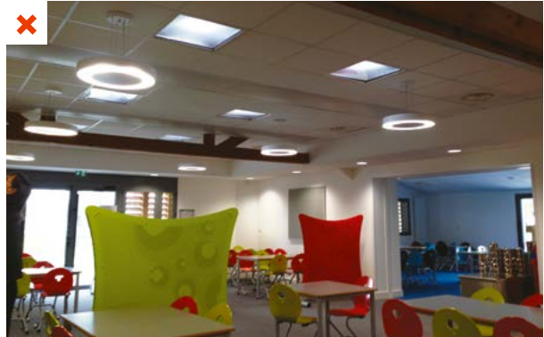
Aucun interrupteur n'est présent. Les luminaires sont directement éteints sur le tableau électrique lorsque le détecteur est défaillant, comme c'est le cas sur cette photo. ©AQC
