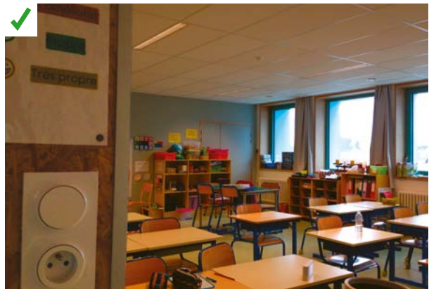
Dans cette salle de classe, le détecteur de présence est couplé à un interrupteur. Il est donc possible de forcer l'extinction des luminaires, notamment lors des projections de supports de cours. ©AQC
