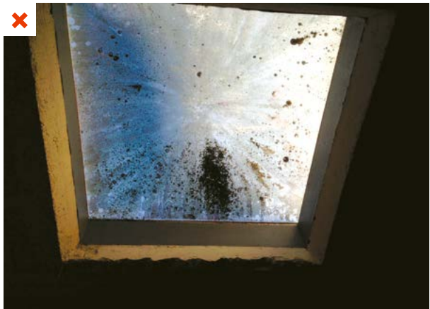
Le lanterneau est encrassé par la présence de végétation et le développement de micro-organismes. L'absence d'entretien régulier restreint l'apport de lumière naturelle. ©AQC
