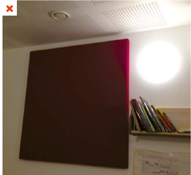
La lampe possède une température de couleur élevée (5 000 K) correspondant à un blanc froid. Ceci n'est pas adapté pour une pièce de repos. ©AQQC
