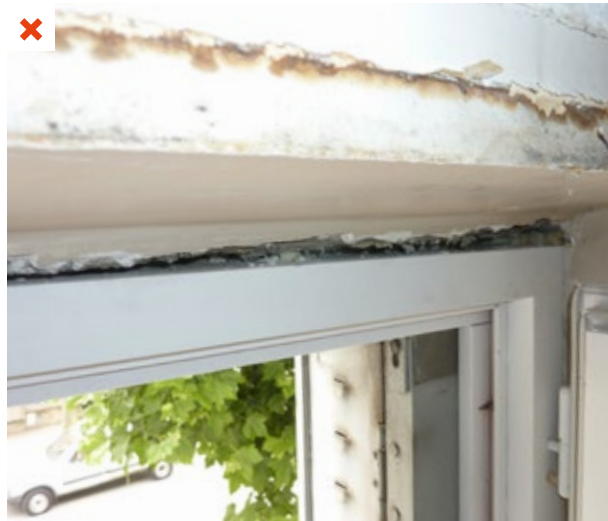
Irrégularité du support qui ne permet pas une pose convenable de la mousse imprégnée pré-comprimée. ©AQC
