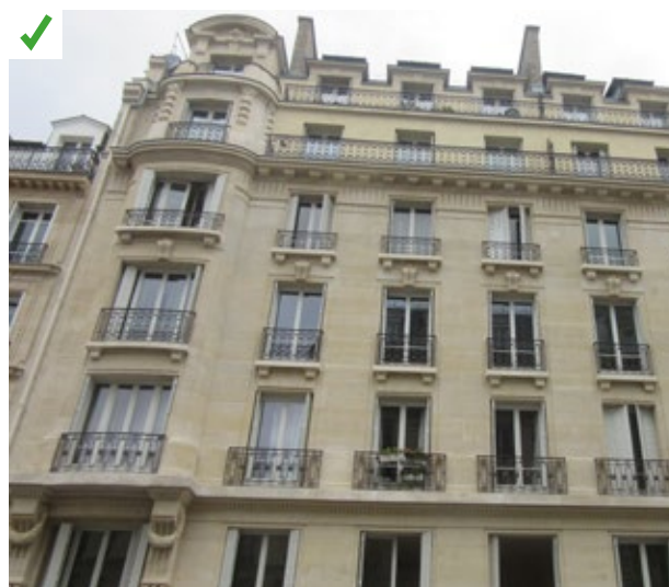
Exemple d'un bâtiment classé où toutes les menuiseries ont été remplacées à l'identique (nature, dimensions, emplacement, quincaillerie, couleurs...) ©AQC
