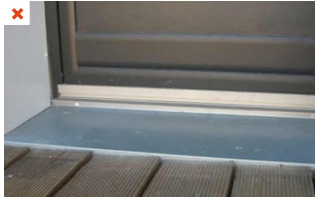
Pose d'un seuil « à la suisse » avec calfeutrement garantissant l'étanchéité à l'air et à l'eau mais non adapté aux PMR. ©AQC
