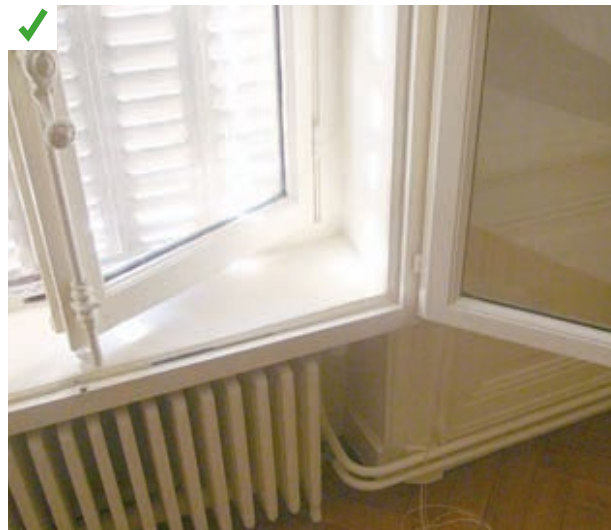
Dans cet exemple, l'aspect extérieur du bâtiment devant être conservé et les menuiseries existantes étant encore en bon état, il a été décidé très en amont et en concertation avec l'entreprise de réaliser un doublage des fenêtres. ©AQC
