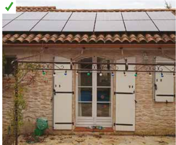
Système de pose en surimposition. Les nouveaux procédés réduisent l'impact visuel des panneaux tout en offrant une lame d'air plus importante qu'en intégration. ©AQC
