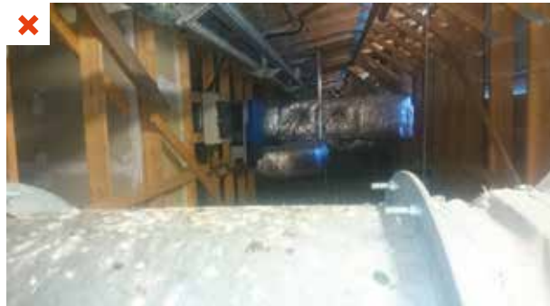
Les gaines de ventilation empêchent l'entreprise de maintenance d'avoir un accès aisé aux onduleurs. ©AQC
