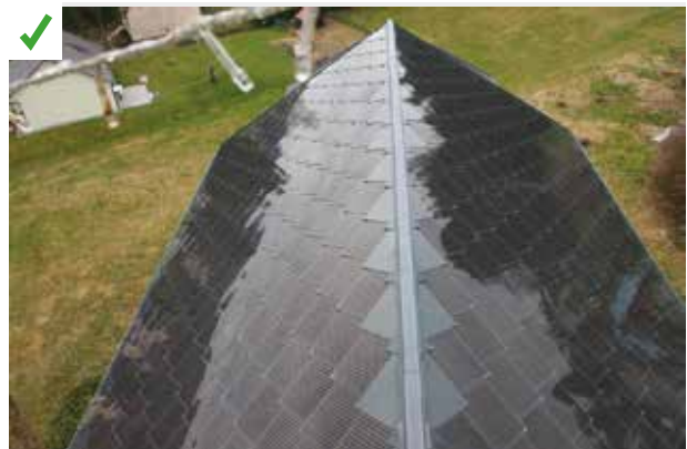
Réfection du toit d'une église avec intégration de tuiles photovoltaïques. La solution d'insertion a été validée par les services publics. ©AQC
