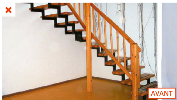
Escalier menant à la cave avant la création d'un sas. © OFSP
