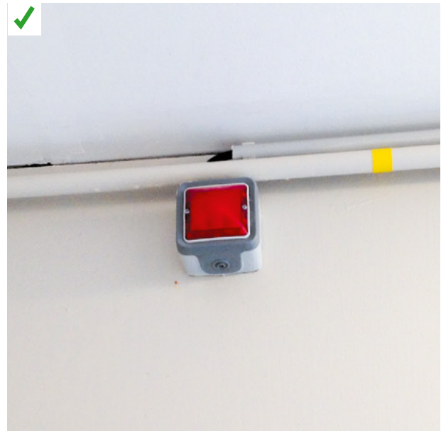
Un témoin lumineux permet d'alerter les occupants d'un dysfonctionnement de l'extracteur. ©AQC
