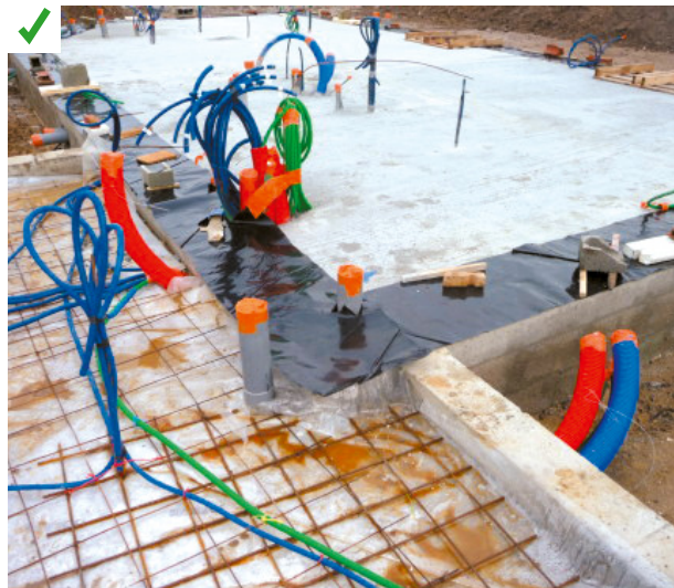
Mise en œuvre de la membrane d'étanchéité comme solution corrective sous les futurs murs en conservant un débord suffisant pour réaliser un raccordement avec le reste de la membrane. © AQC
