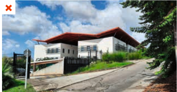
Le positionnement de cet ouvrage a été pensé pour limiter les opérations de terrassement et avoir le moins d'impacts visuels possible. La localisation de l'ouvrage sur la pente et sous le vent, réduit le potentiel de ventilation naturelle au sein de l'ouvrage.
