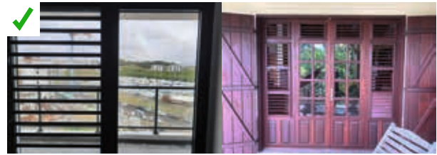
Menuiseries mixant vitrage plein et jalousies ou ventelles. À droite, les ventelles sont réglables individuellement. La présence de volets permet d'apporter une protection en cas de vent cyclonique. ©AQC
