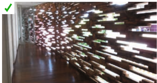
Réalisation d'un mur en moucharabieh permettant la ventilation de cette circulation et l'évacuation des fumées. ©AQC
