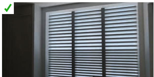
Ventelles fixes (type lame Z) dont l'espacement permet de garantir le respect des normes incendie. L'écart dégressif vers le bas contribue à la protection contre les intempéries. ©ANCO
