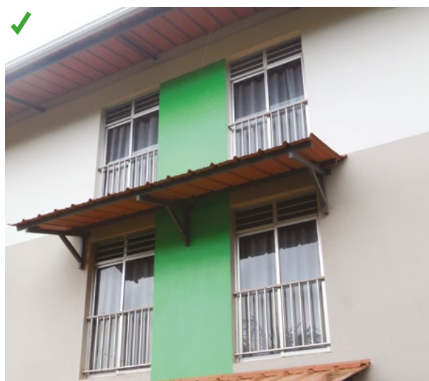
Jalousies placées en position haute et protégées par des auvents. ©AQC
