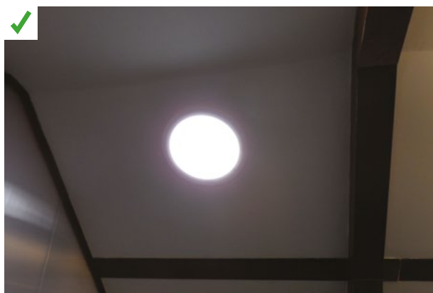
Canon à lumière naturelle dans un bureau installé dans les combles. ©AQC
