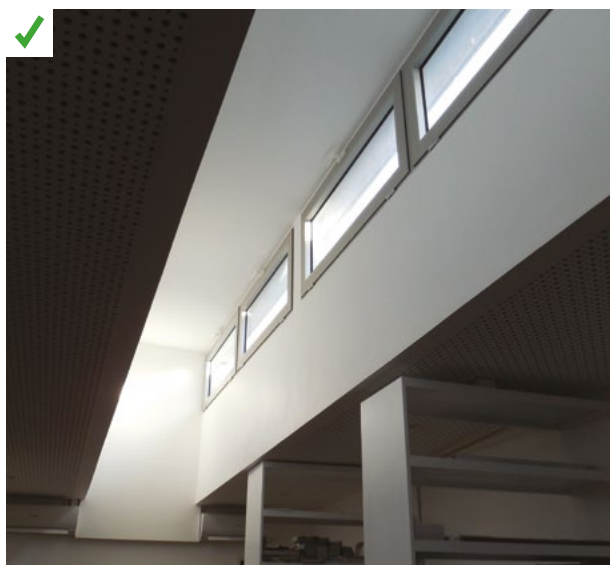
Puits de lumière orienté Ouest captant le soleil d'après-midi et de fin de journée, limitant l'usage d'éclairage électrique. Associé à une ventilation naturelle efficace, il apporte un confort visuel très important aux usagers, sans occasionner de surchauffe. ©AQC
