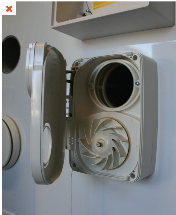
À haut régime, les pales de ce ventilateur génèrent des turbulences de l'air sources d'un bruit important. ©AQC
