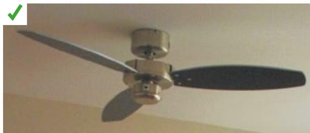
*Dans cette chambre de 12 m<sup>2</sup>, un brasseur d'air de qualité, bien positionné et au diamètre suffisant assure le confort thermique. Bâtiment collectif. ©AQC*
