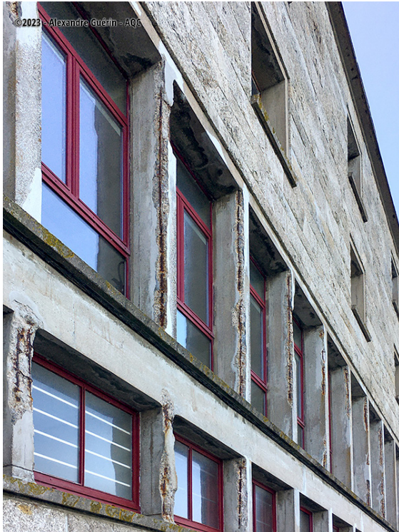
Façade en béton exposée à l'air marin. Les armatures corrodées sont visibles à la suite de l'éclatement du béton.
