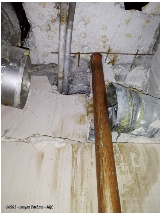
Façade en béton exposée à l'air marin. Les armatures corrodées sont visibles à la suite de l'éclatement du béton.
