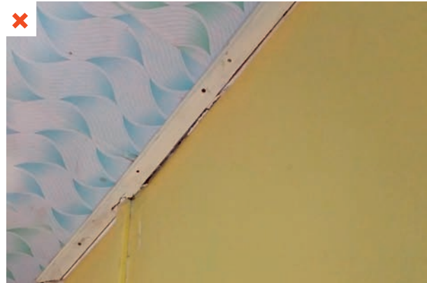
L'étanchéité à l'air n'est pas assurée à la jonction entre le mur et le faux plafond. ©AQC
