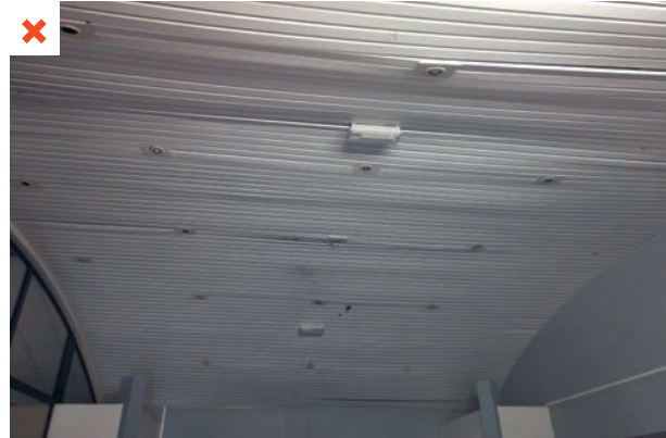
Sous le poids de l'isolation rapportée et du fait du sous-dimensionnement de la structure du plafond suspendu, le parement PVC se déforme. ©AQC
