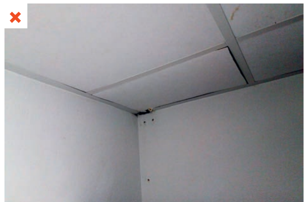
Apparition de poussières provenant des combles. Le faux plafond, ou plafond modulaire, est réalisé en dalles posées sur structure et n'assure pas l'étanchéité à l'air. ©AQC
