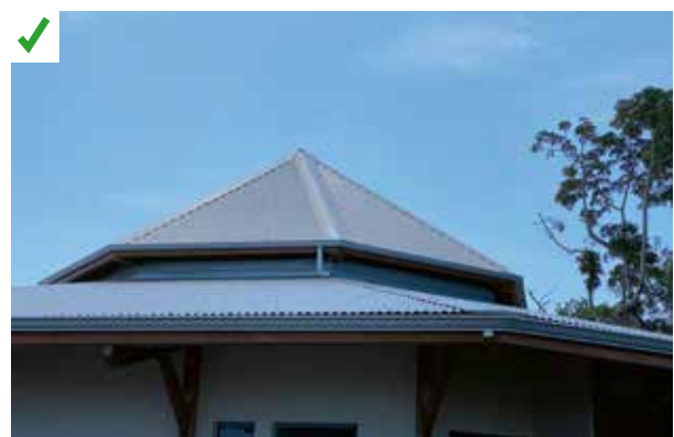
Couverture de couleur claire à moyenne limitant les risques d'encrassement tout en bénéficiant d'une faible absorption solaire. ©AQC
