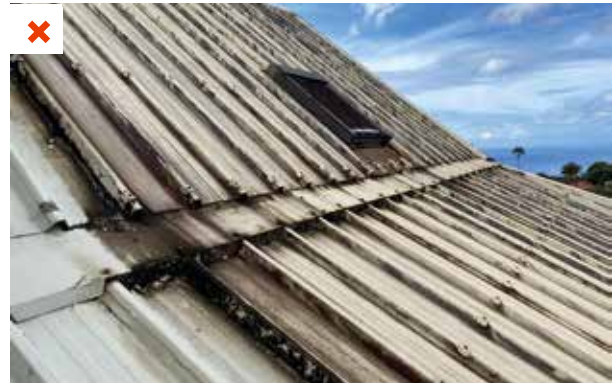
Développement de moisissures sur la toiture. L'absorption solaire devient plus importante et entraîne une hausse de la transmission de la chaleur vers l'intérieur. ©AQC
