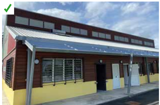
Ventelles sous toiture - Vue extérieure. ©AQC
