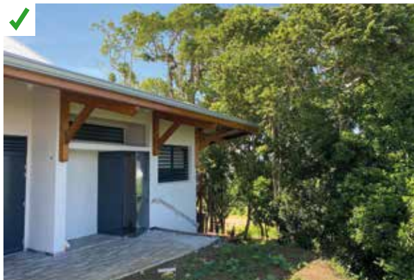
Apport d'ombrage sur la toiture par la végétation dense à proximité du bâtiment. ©AQCC
