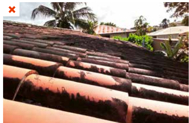
L'encrassement des tuiles engendre une baisse de performance thermique de la couverture. Les zones noircies ont une absorption solaire plus importante. ©AQC
