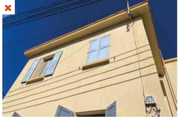
Toiture non ventilée. ©AQC
