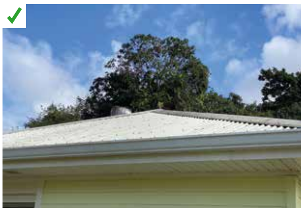
Toiture de couleur claire. ©AQC
