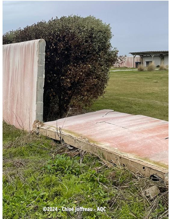
*Chute d'un mur de clôture par absence de chaînage.*
